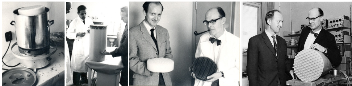
Fig. 5. Nipplarna tillverkas: från vänster vaxsmältning; gjutning Carl Gustaf Bernhard skymtar till vänster, Urho Kuhmonen (ingenjör), och till höger Sven Karlsson (instrumentmakare); färdig nippelmodell i handen på Aage Møller till vänster och Carl Gustaf Bernhard med gjutformen till höger; bilden längst till höger Aage Møller & Carl Gustaf Bernhard.
